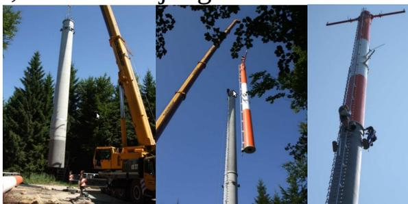
77 cm. In nächster Zeit wird noch die Sendetechnik montiert und installiert, damit der Betrieb im September dieses Jahres aufgenommen werden kann. Diese Antennen werden den Mast weitere 4 m überragen. Nach Abschluss
